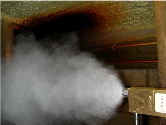
図1. Ultimix 操作(商業農場)におけるノズルと制御バルブ。
